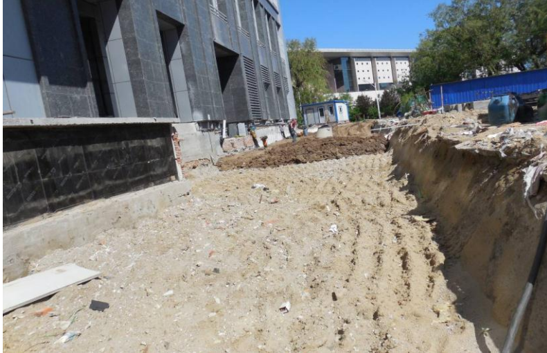
散水坡土方开挖
