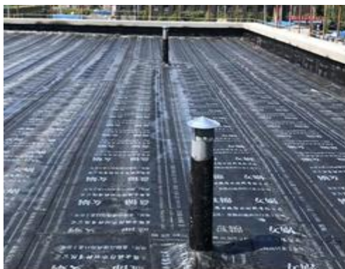
屋面防水施工
